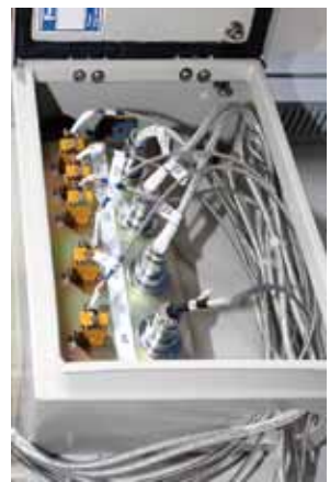
ヒータ接続盤
